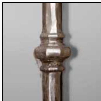
Esempio di inquinamento da Agenti esterni quali Pulviscolo e smog Example of a stainless steel picket polluted by external agents like dust and smog
